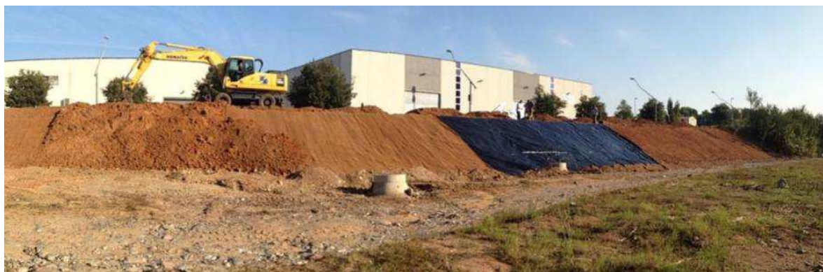
Imagen de un talud en el río Congost en Montmeló (Barcelona) donde se pueden ver las diferentes fases del proceso de cubrimiento. De derecha a izquierda: escollera regularizada con tierra. Plástico negro. Red de coco. Aporte de tierras. Tierras reperfiladas.
