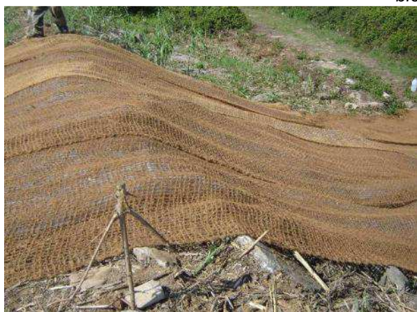
Trabajos de cubrimiento de la escollera
