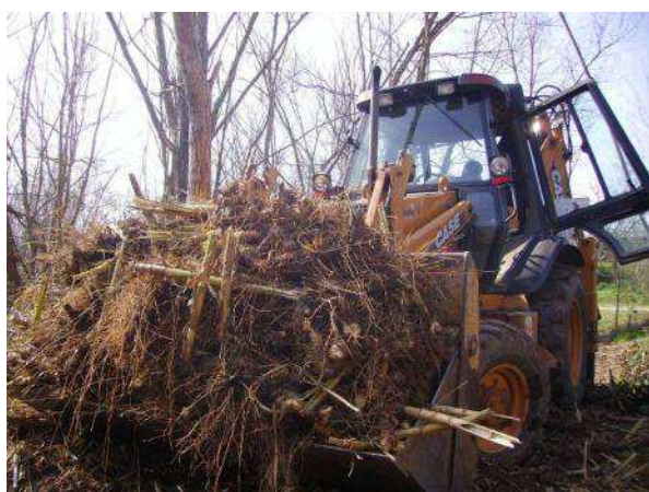
Retroexcavadora realizando tareas de retirada de la caña y el rizoma.
